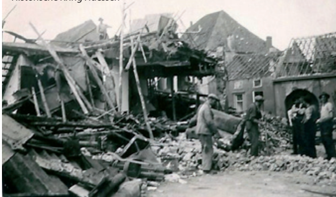
Schade door het bombardement in de Vierakkerstraat Historische Kring Huessen
